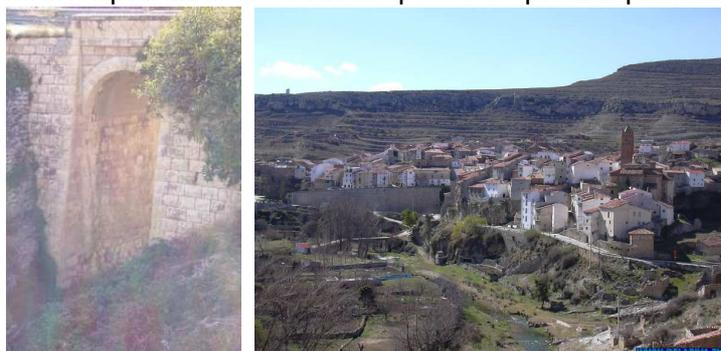
**Puente de la Huerta.** Sobre el río Martín, a su paso por las huertas de Obón, se encuentra este puente de unos veinte metros de longitud en su tablero horizontal. Bajo dicha superficie, dos pilares de importante robustez soportan el peso permitiendo el paso del discurrir del río sin ningún problema, dejando los muros laterales que se adaptan al terreno en el que se adosan.
